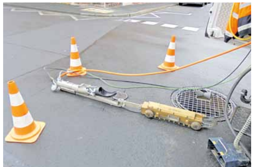
Der steuerbare Kamerafahrwagen kurz vor dem Abtauchen in die Kanalisation Bad Kissingens
